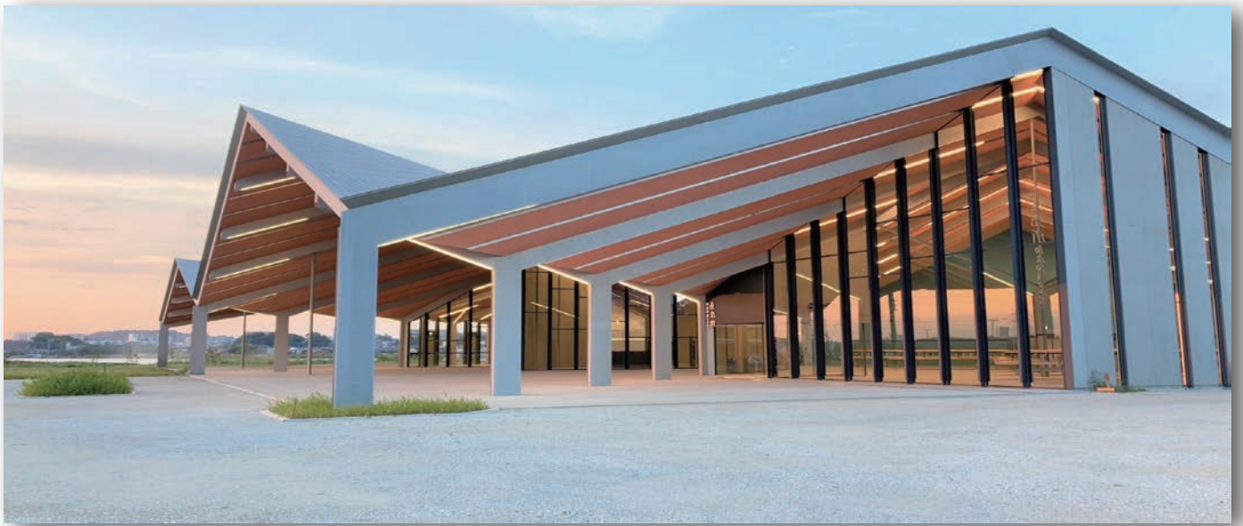
道の駅しょうなん新築工事
