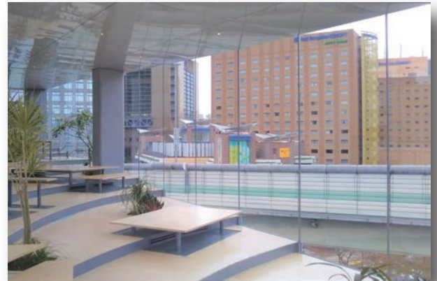
ナインアワーズ水道橋新築工事
